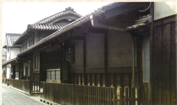
春風館・復古館〈国重要文化財〉
